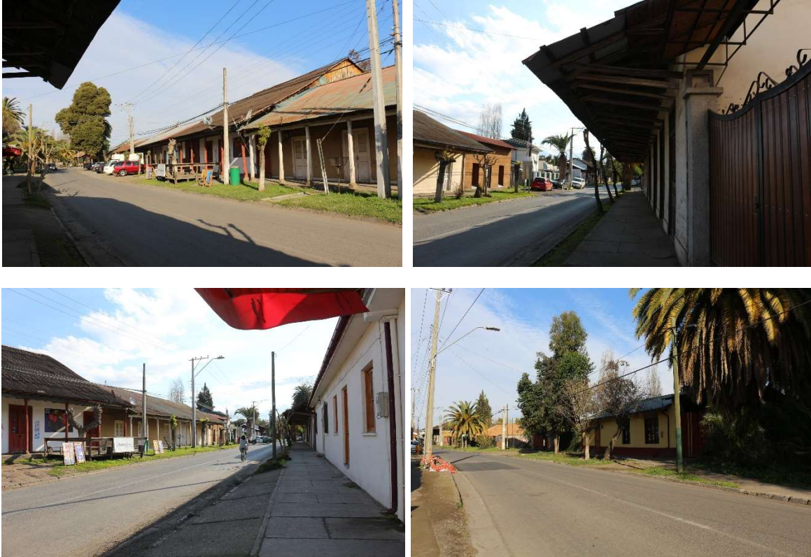
Figura 50: Imágenes de Edificaciones en Avenida Cardenal Caro.
