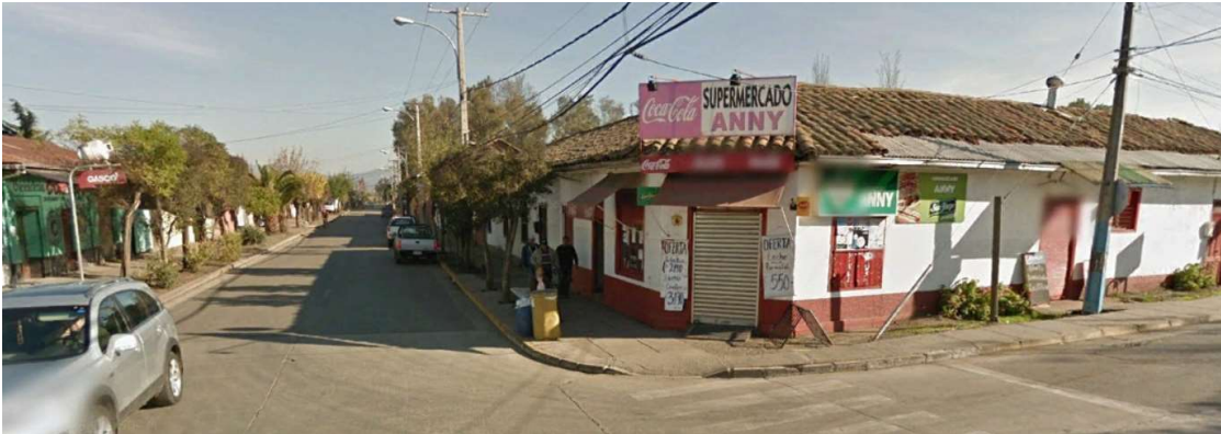
Figura 55: Imagen de Edificaciones Avenida Argomedo.
