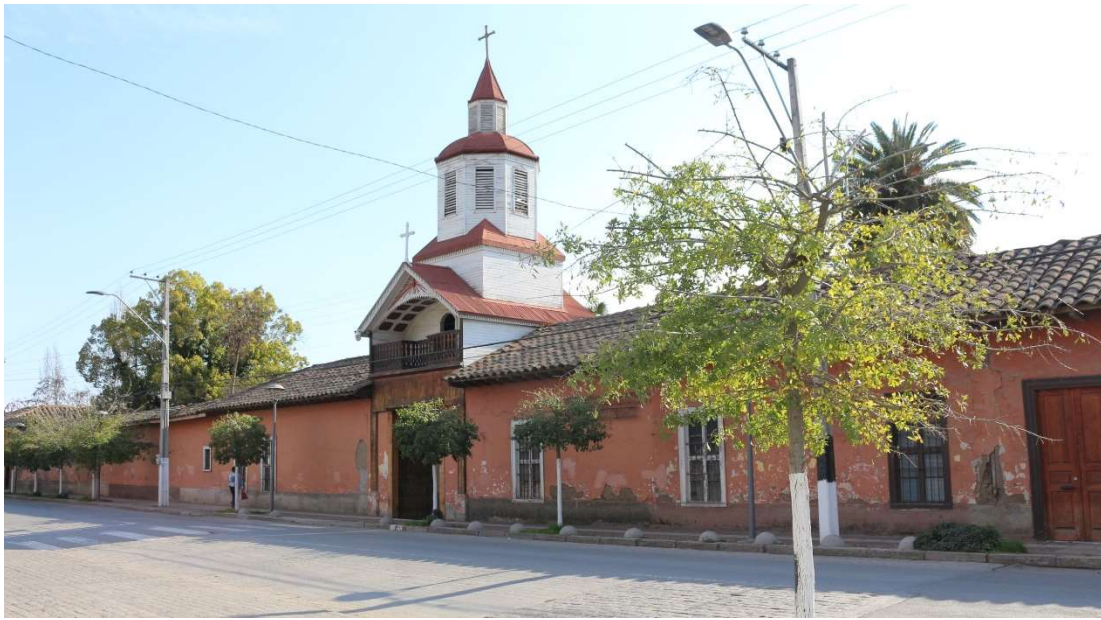
Figura 52: Imagen de fachada de edificio Casa de Ejercicio Cailloma.
