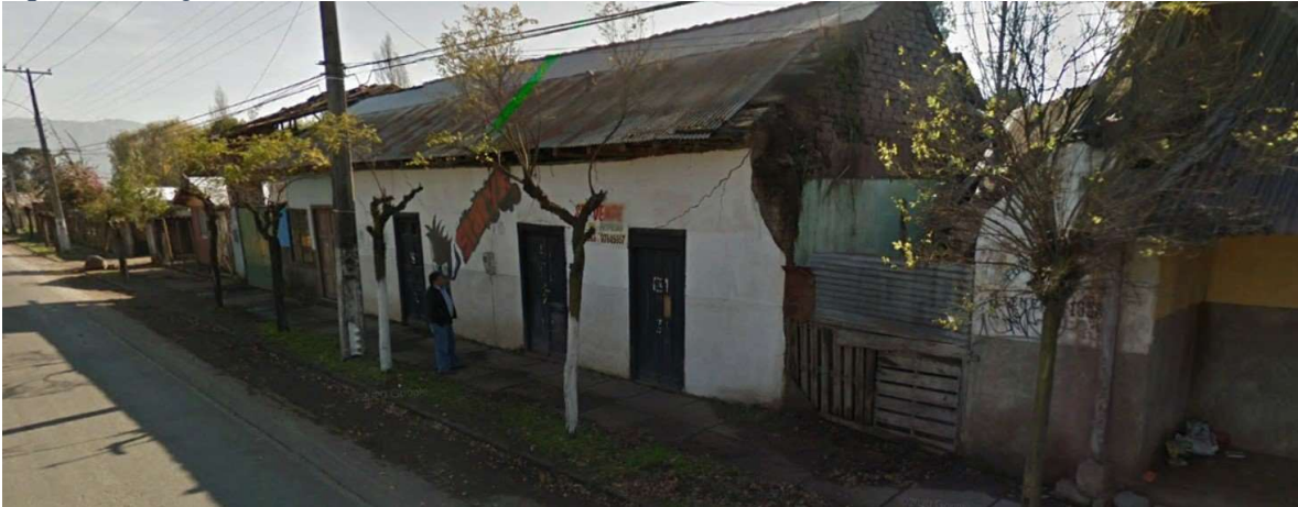
Figura 58: Imagen de Edificaciones acceso norte a localidad de Quinta de Tilcoco.
