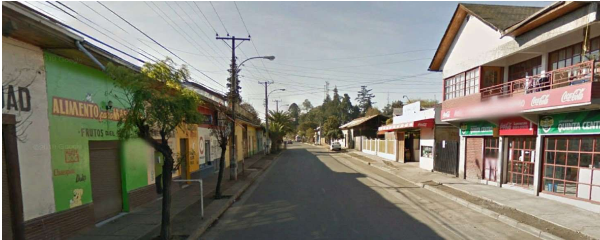
Figura 56: Imagen de Edificaciones de Avenida Argomedo
