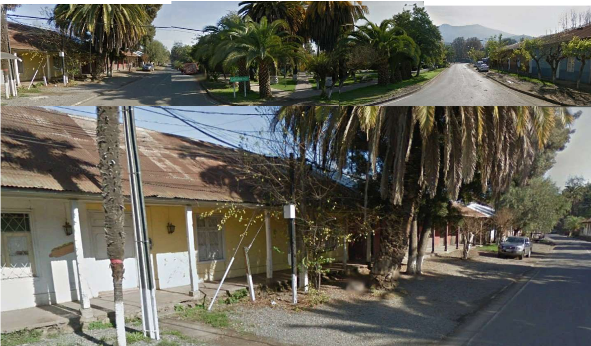
Figura 49: Imagen edificaciones frente a la Plaza de Guacarhue.
